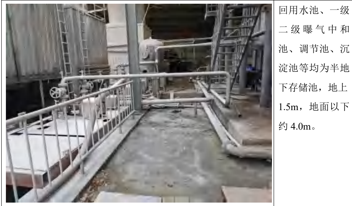
图4.1.3-1 污水处理区域现状图
