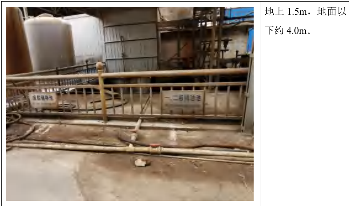
图4.1.3-1 污水处理区域现状图
