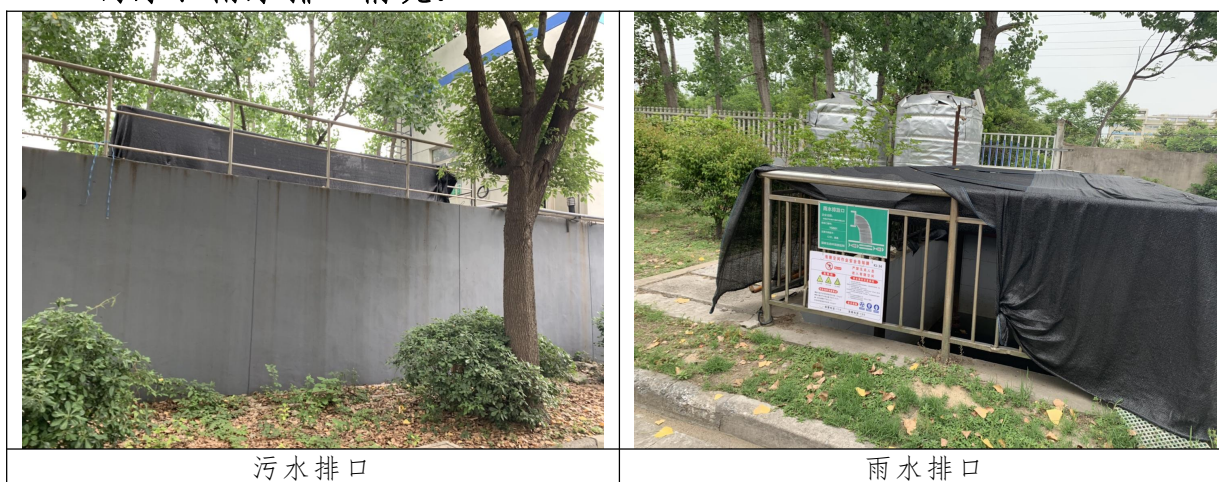
图 4-1 污水排口、雨水排口图示
